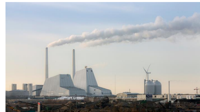
El- og fjernvarme
