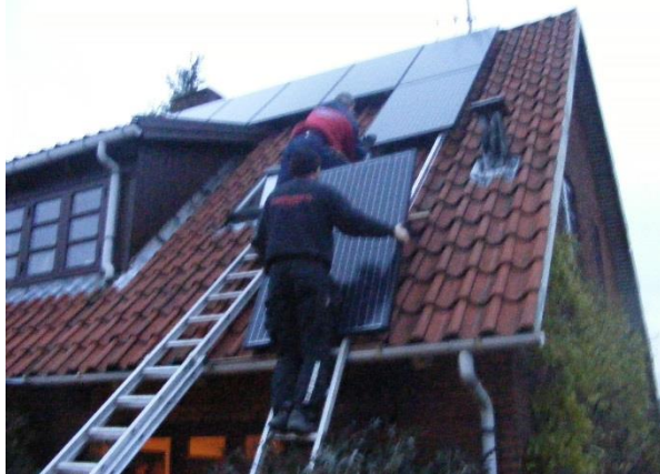
Samarbejde tømrer elektriker
